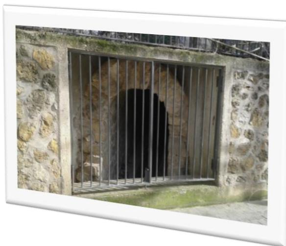
Le bassin bâti en moellons, situé à Wissous, et alimenté par les sources environnantes, mesure 4 m de côté et 1,70 m de hauteur. Celui-ci possédait une pente étudiée afin d'assurer un écoulement parfaitement régulier. Il franchissait la Bièvre en aval de
